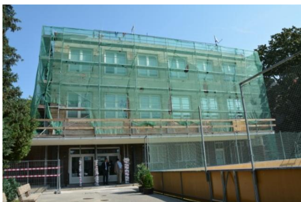
Pohľad na priečelie rekonštruovanej budovy Základnej školy kniežat'a Pribinu v Nitre.
