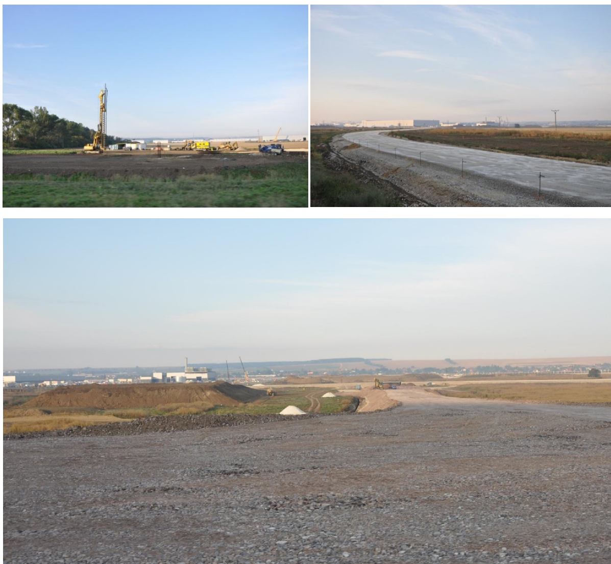
Výstavba okružnej križovatky na kopci pod dražovským kostolíkom – 9/2017.
