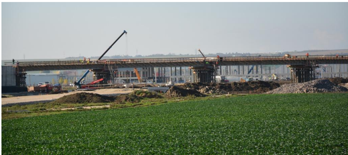
Výstavba nadjazdu - hlavný dopravný koridor k automobilke Jaguar Land Rover – 5/ 2017.
