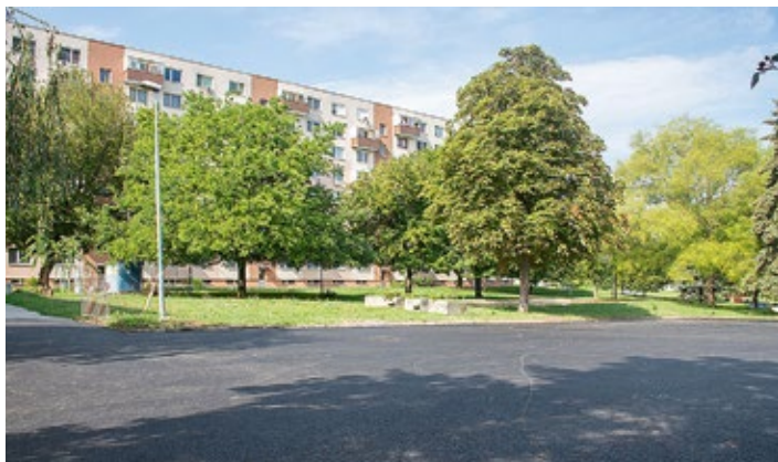
Obnovené parkovisko pred ZŠ Benkova
