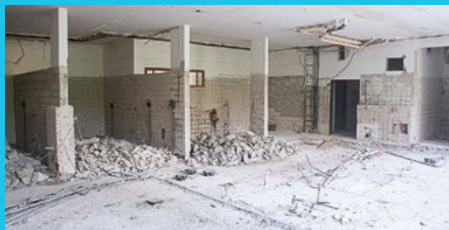
V kuchyni počas rekonštrukcie zostali stáť len steny
