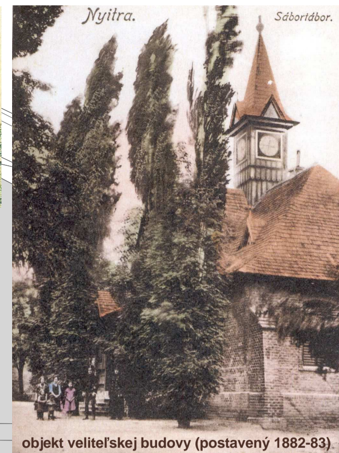
objekt veliteľskej budovy (postavený 1882-83)
