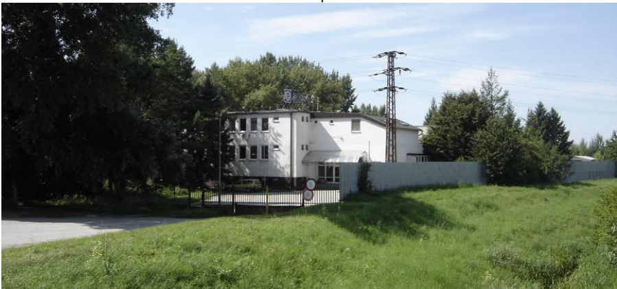
obr. 14: PFCelok Šindolka – areál vodárenského podniku
