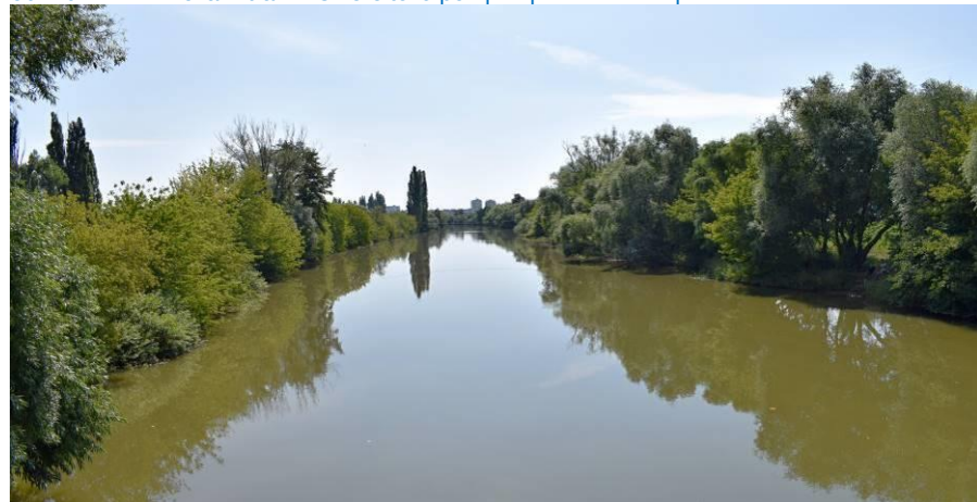
obr. 7b: NRBK Rieka Nitra – v smere toku pod protipovodňovou úpravou
