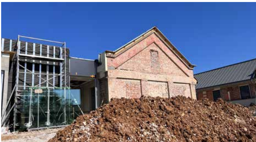
V areáli bývalých kasární sa rekonštruje takmer 3000 m 2 .
