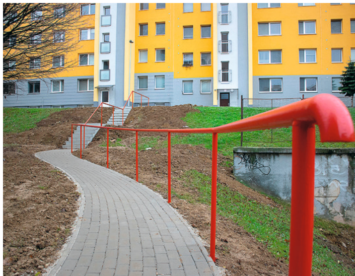
Schody a chodník na Považskej - Z radov občanov prišla požiadavka na spevnenie frekventovanej cestičky vo vnútrobloku. Stredisko mestských služieb sa postaralo o dobudovanie chodníka aj o postavenie schodov a osadenie zábradlia.
