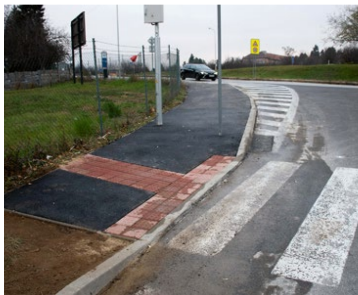
Čermáň, Hlboká - rozšírenie chodníka
