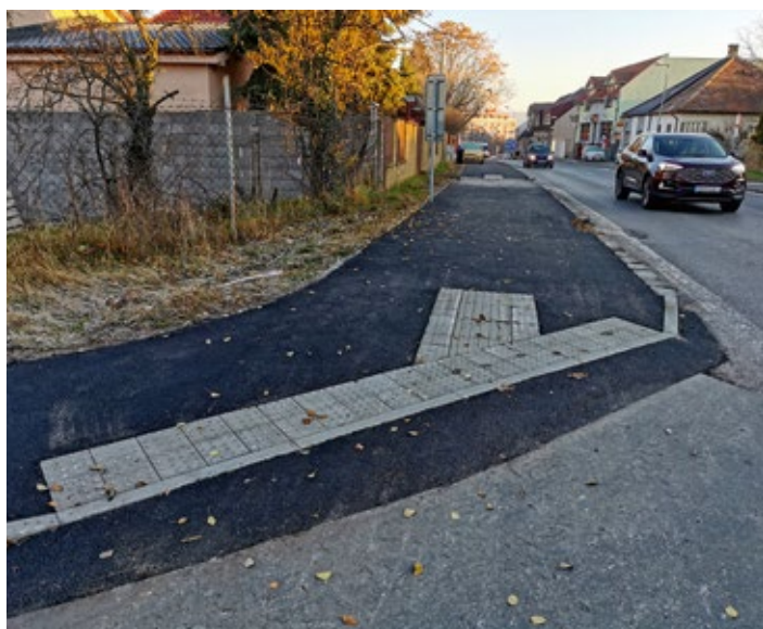
Staré mesto, Braneckého - bezbarierové nájazdy chodníka
