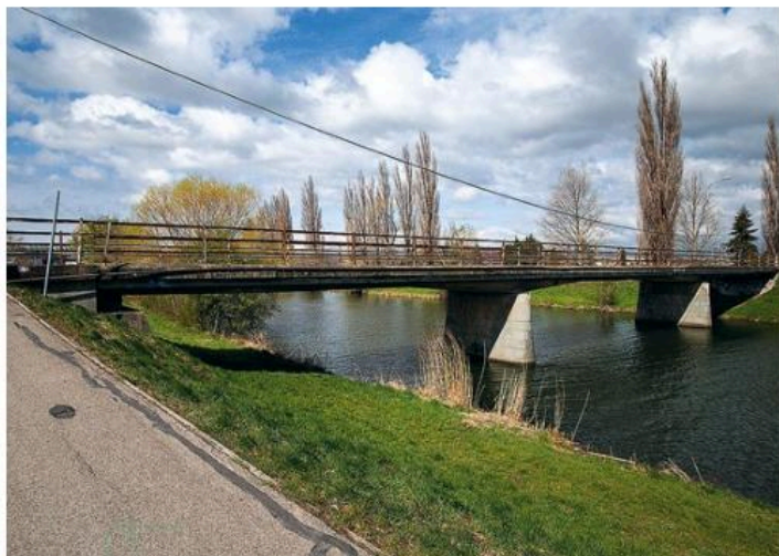
Most na Vodnej ulici.
