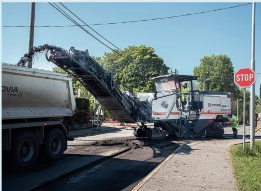
Na Hlbokej ulici na Čermáni (VMČ 2) sa opravoval povrch miestnej komunikácie
