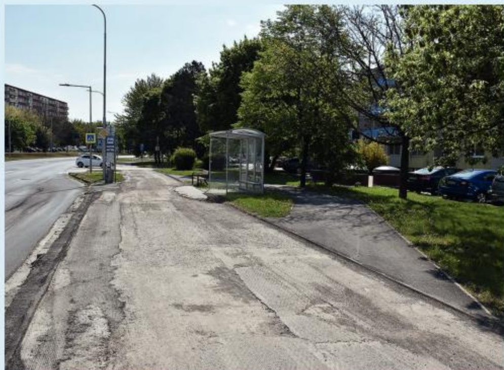
V rámci VMČ 7 sa na Chrenovej koncom apríla začalo s frézovaním spevnených plôch na Vihorlatskej 2-4, a aj chodníka na Dlhej ulici, ktorý bude po položení nového povrchu využívaný aj ako cyklochodník.
